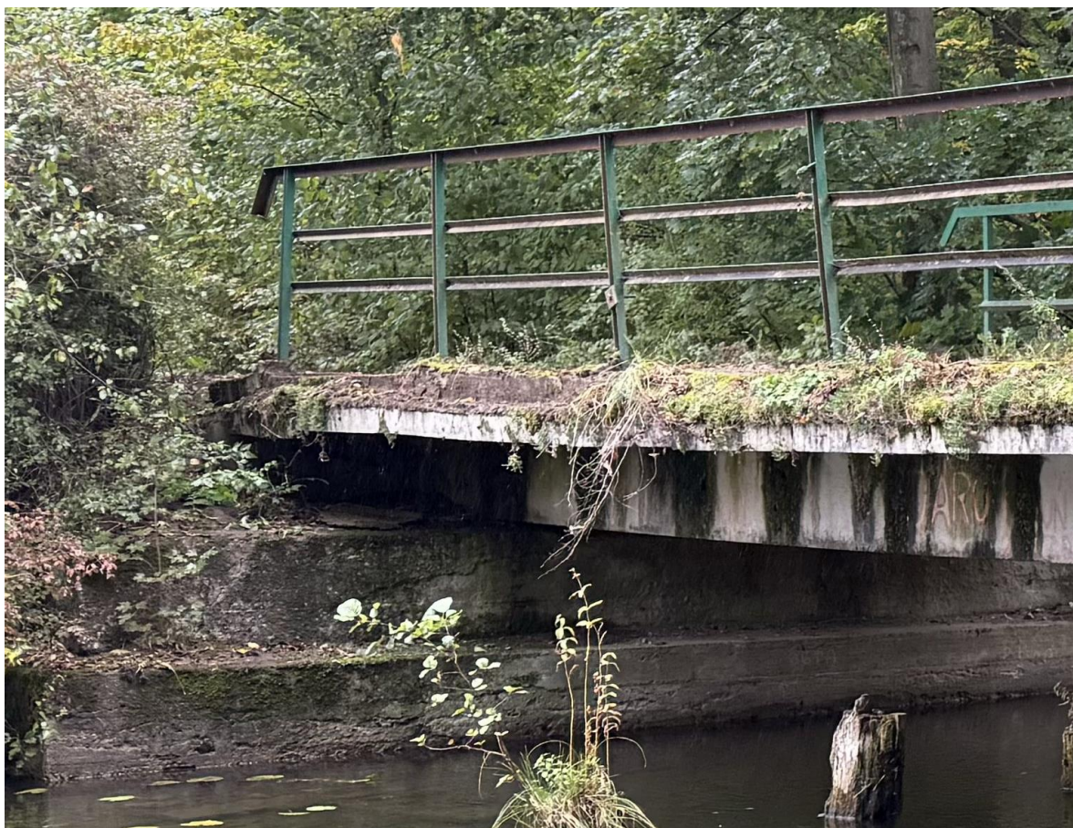
Fot. 2. Uszkodzenia widocznego fragmentu przyczółka betonowego w postaci ubytków betonu, wykruszeń i deformacji betonu. Na całej powierzchni betonu przyczółka widoczne są zielone zacieki i wykwyty.
