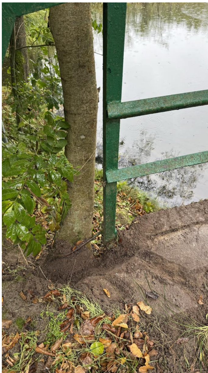
Fot. 11. Drzewa, krzewy i trawy porastające skarpy. Widoczne także zanieczyszczenia gruntem elementów konstrukcji mostu.
