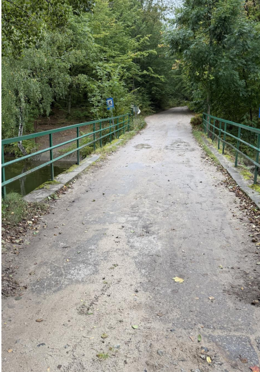
Fot. 1. Ogólny widok mostu. Widoczne uszkodzenia nawierzchni mostu i zanieczyszczenia gruntem oraz suchymi liśćmi. Powierzchnia opaski porośnięta mchami.
