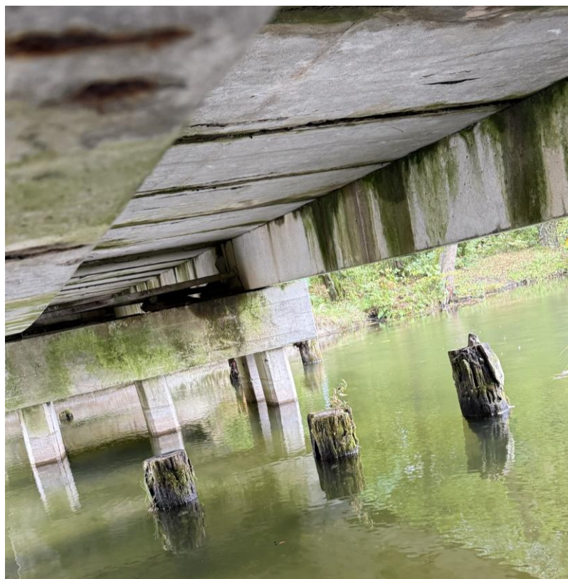
Rys. 6. Widok belek żelbetowych z dołu. Występują ślady korozji zbrojenia zwłaszcza na ich dolnych powierzchniach. Belki te mają również niewielkie ubytki betonu. Widoczne ciemnozielone zacieki na belkach.
