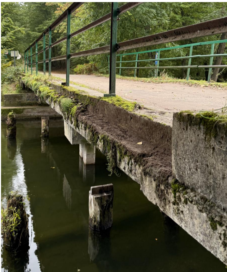
Fot. 8. Miejsca po brakujących elementach gzymsowych. Na istniejących elementach występują niewielkie spękania, zarysowania i ubytki betonu. Powierzchnia zewnętrzna jest porośnięta mchami, które powodują powstanie wykruszeń w betonie.
