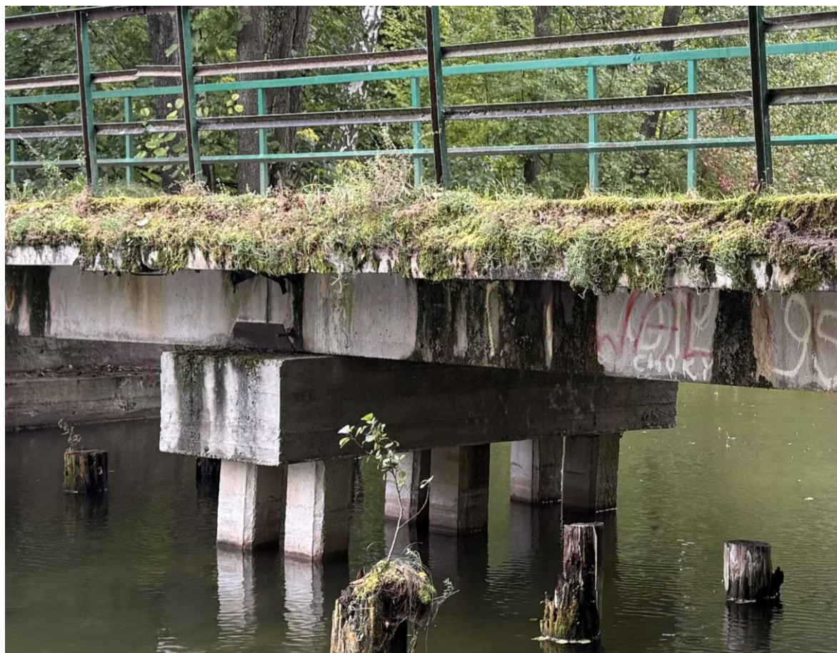
Fot. 4. Podpora pośrednia wraz z oczepem. Niewielkie uszkodzenia słupów i oczepu w postaci ubytków betonu, wykruszeń i deformacji betonu. Na całej powierzchni zwłaszcza betonu oczepu widoczne są zielone zacieki i wykwyty. Na oczepie widoczne są zanieczyszczenia gruntem
