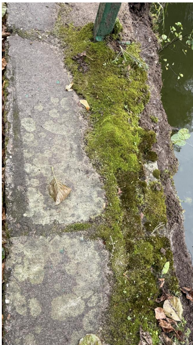
Fot. 10. Na nawierzchni mostu są duże spękania i znaczne ubytki materiału. Strefa przy opasce jest zabrudzona i porośnięta nieliczną roślinnością. Betonowa opaska miejscami ma niewielkie ubytki, wykruszenia i spękania, zalega na niej gruba warstwa gruntu i porośnięta jest roślinnością, a zwłaszcza mchami.
