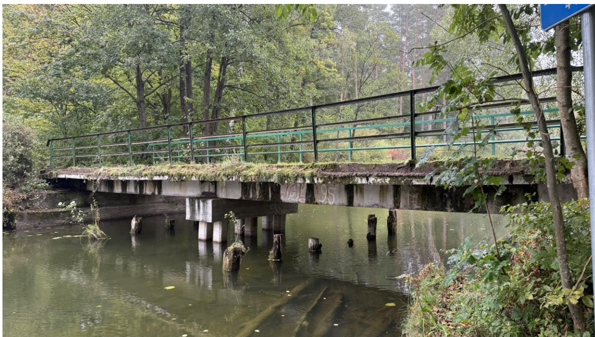
Rys. 5. Widok belek żelbetowych z boku. Widoczne ciemnozielone zacieki na belce.
