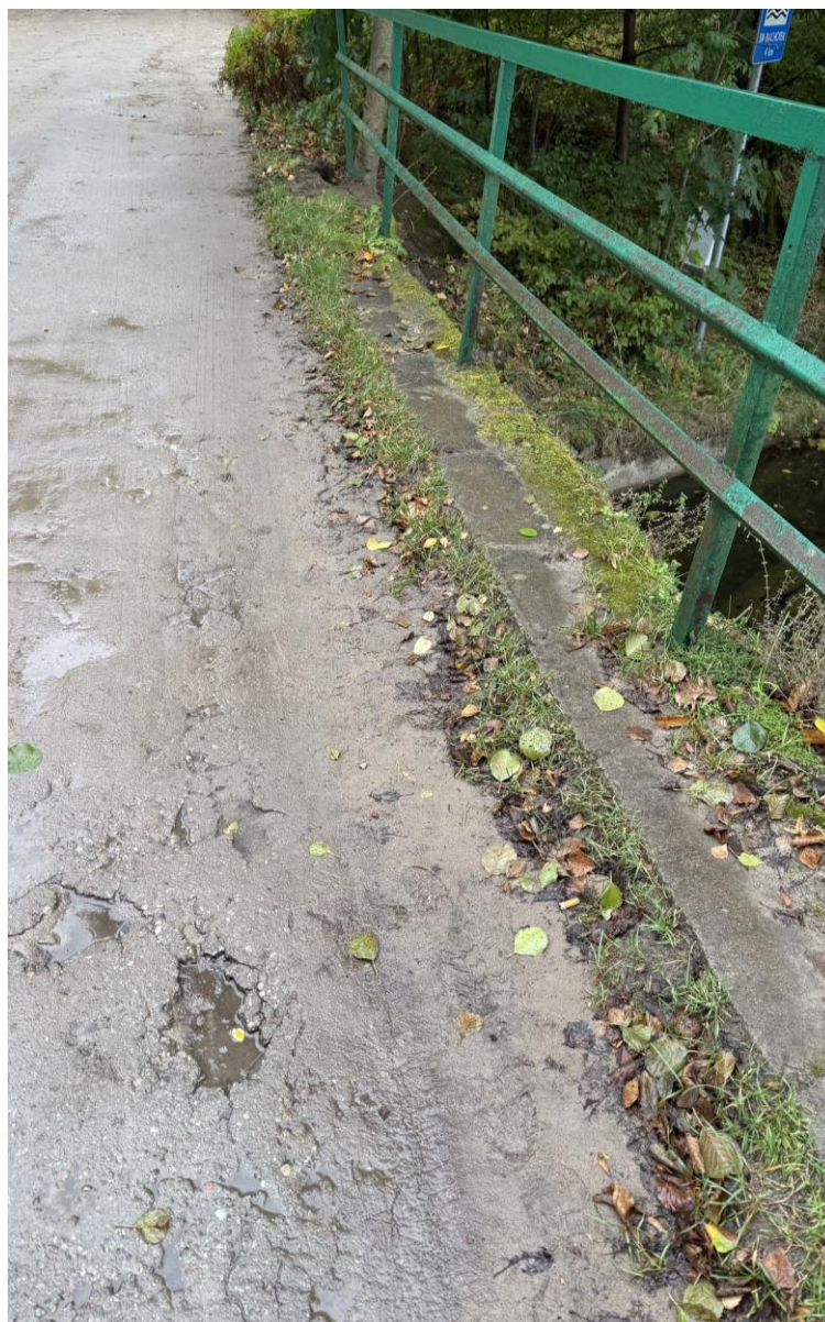
Fot. 9. Uszkodzenia nawierzchni na moście, która nie osłania hydroizolacji i powoduje jej uszkodzenia.
