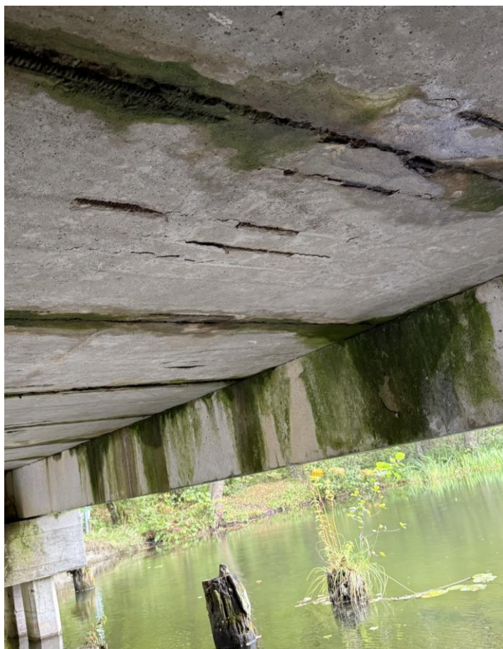
Fot. 7. Żelbetowe płyty pomostu wykazują ubytki betonu w dolnej i na bocznej powierzchni. W wielu miejscach widoczne są nieosłonięte otuliną pręty zbrojeniowe, największe ubytki są w miejscu styku między płytami. Na powierzchni płyt widoczne są ciemnozielone zacieki.
