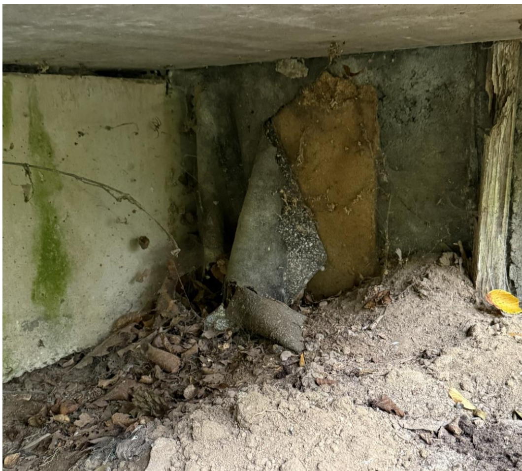
Fot. 3. Oparcie belki żelbetowej na przyczółku. Widoczne są zanieczyszczenia gruntem i suchymi liśćmi. Widoczne są także pozostałości warstwy izolacyjnej w postaci papy.
